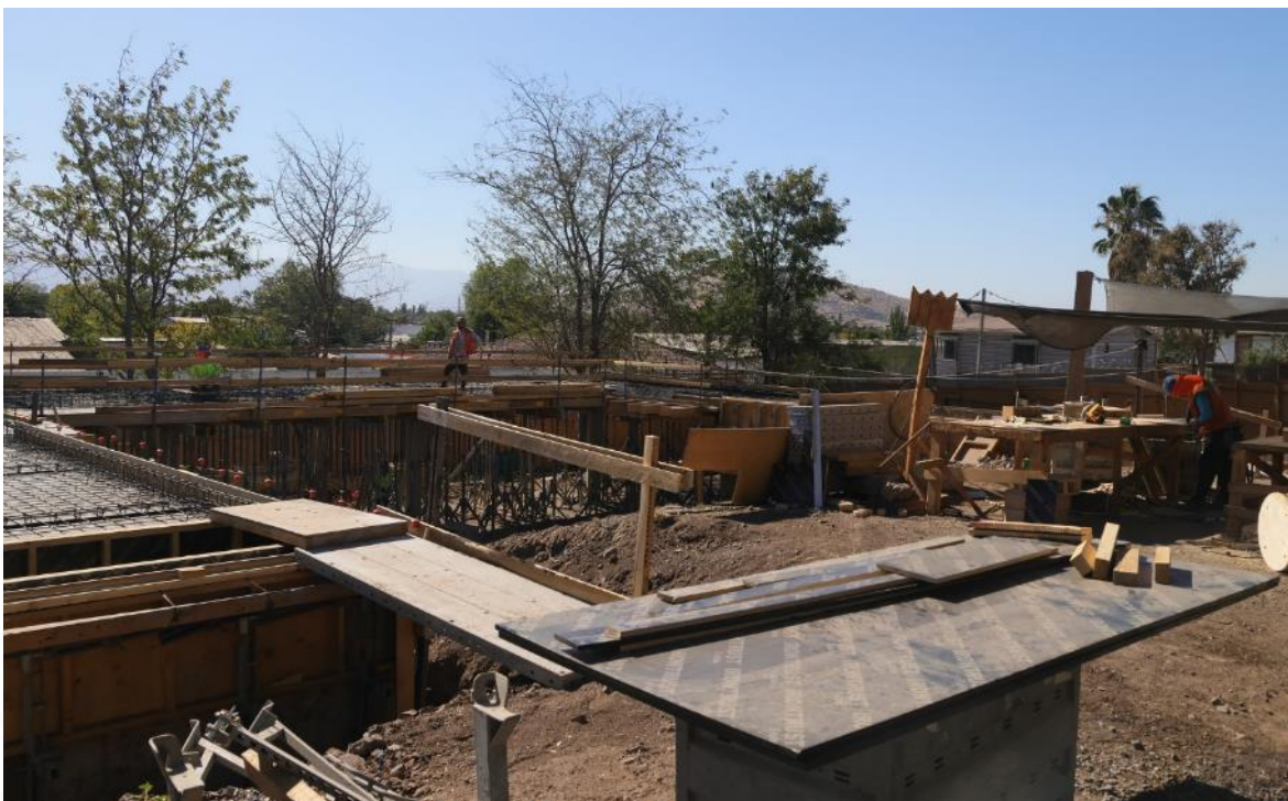
Imagen 8: Avance de obras Parque Cerro Navia.
