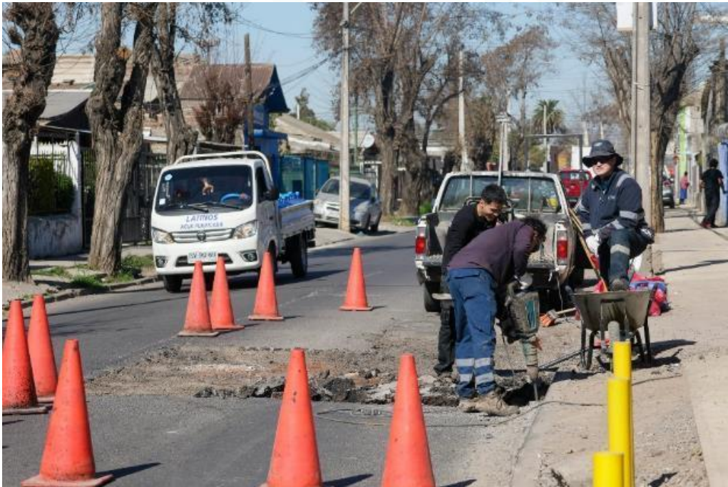
Ilustración 10: Equipo de bacheo en reparaciones.
