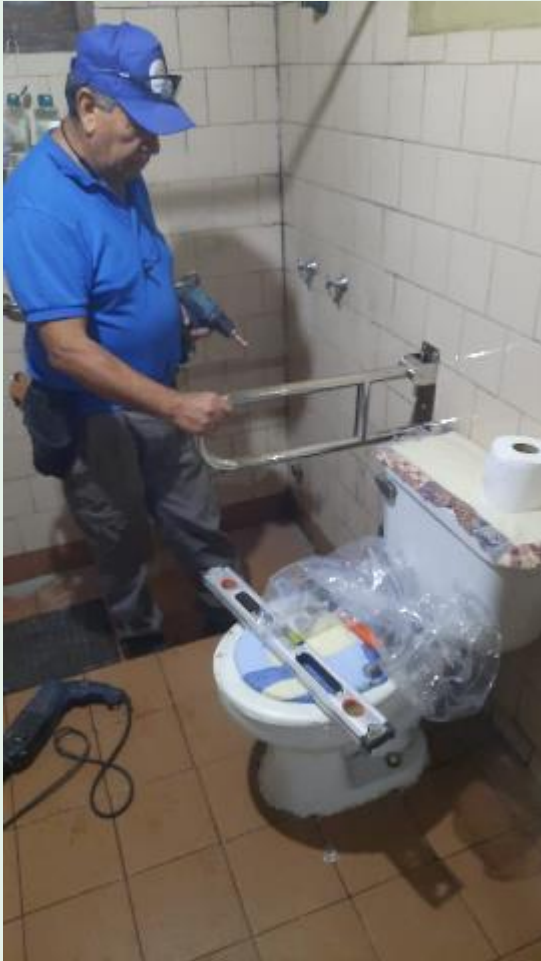
Fotografía 19 obras de accesibilidad para la vivienda
