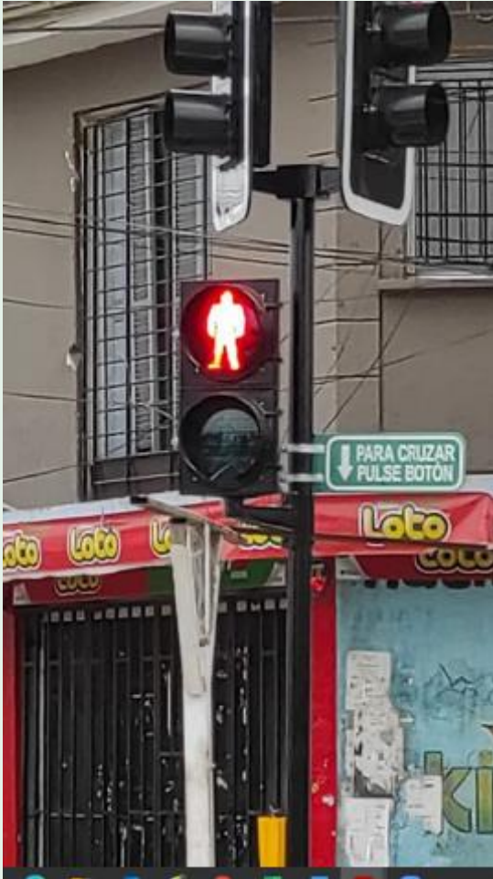
Fotografía 87. Instalación de semáforo ubicado en Luis Lazzarini - Huelén.
