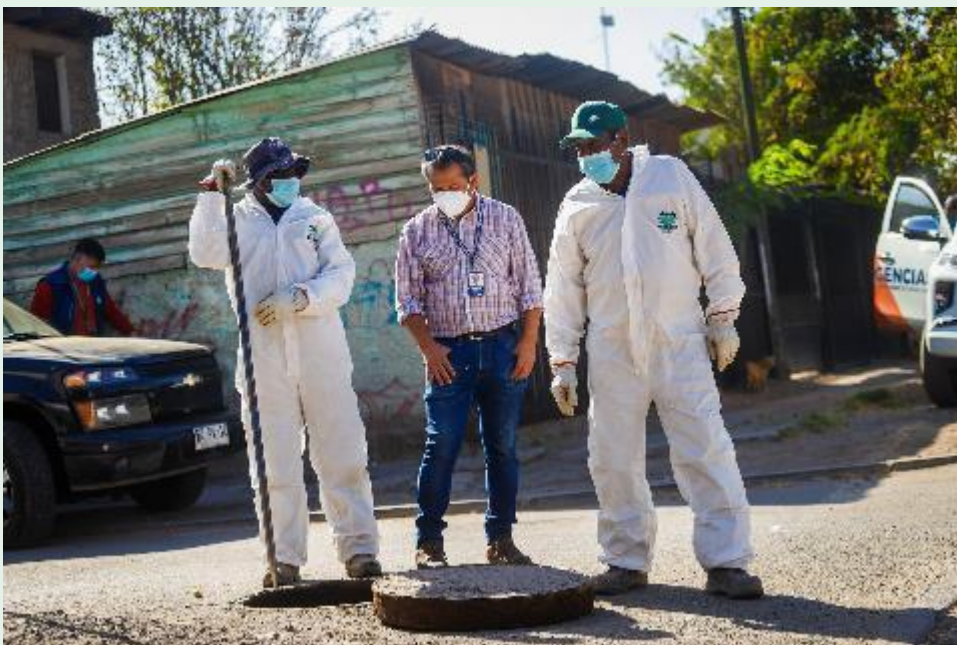
Fotografía 78 Reparación veredas y de sumideros en calle Padre Liam Holohan
