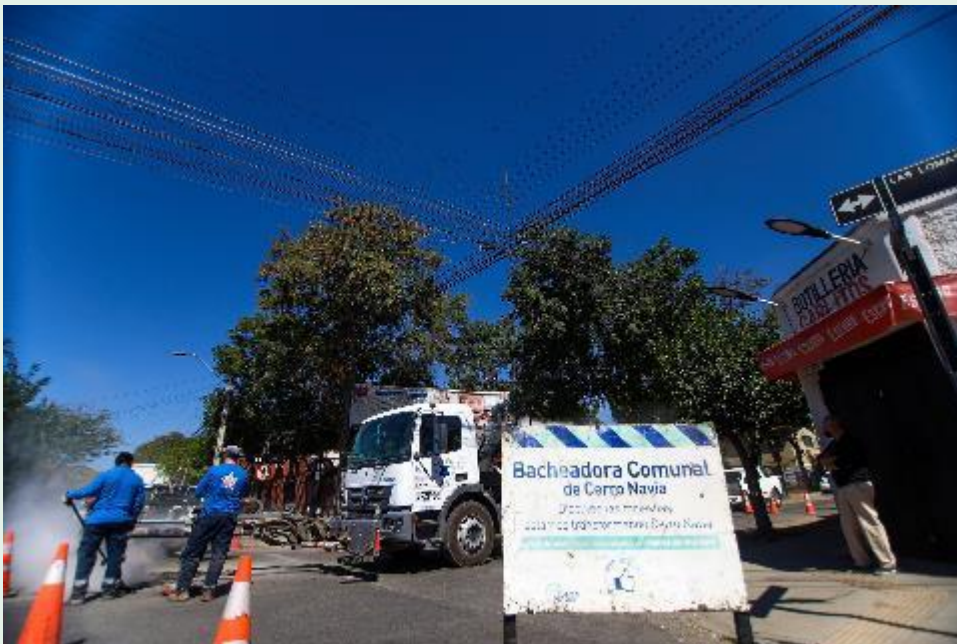
Fotografía 81 Reparación de baches en calle Ñancu
