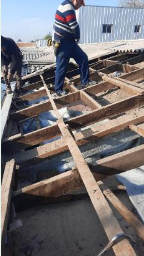
Fotografía 18 Mejora de vivienda
