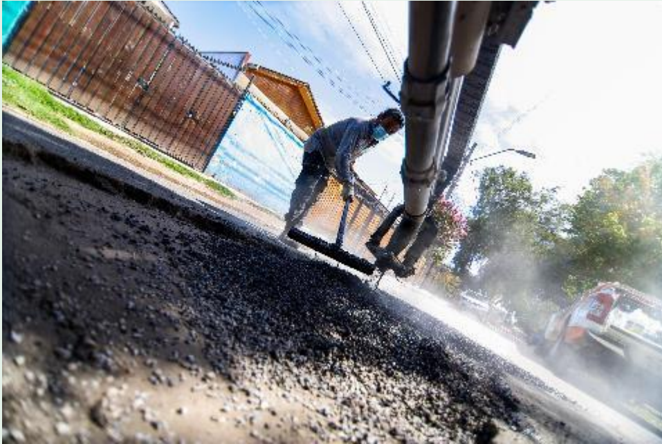
Fotografía 80 Reparación de baches en Miraflores N°1527
