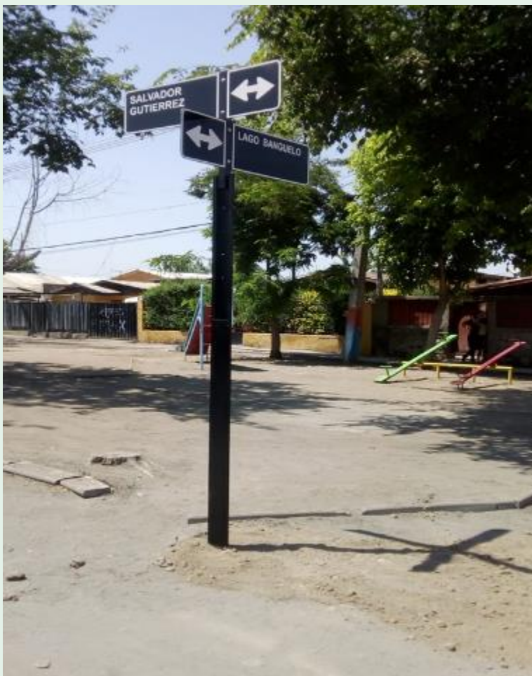
Fotografía 86. Instalación de señalética vertical
