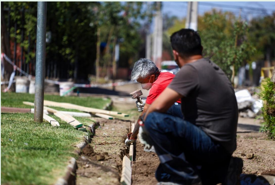
Fotografía 83 Reparación de veredas en la UV3 Almirante Grau y Las Siempre Vivas
