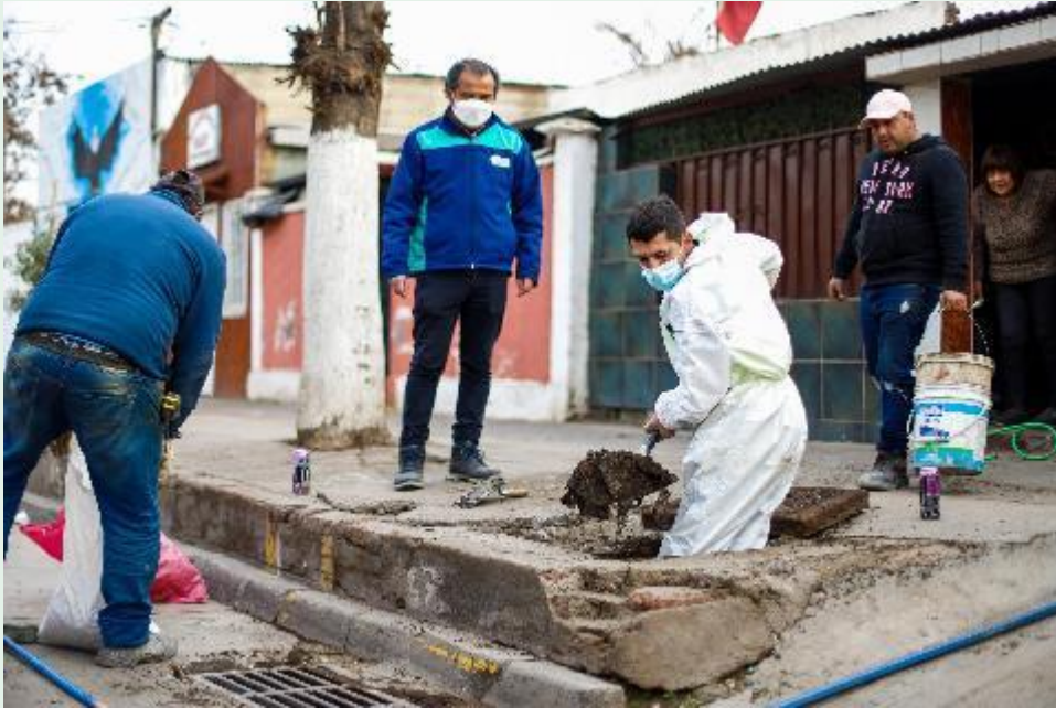
Fotografía 77 Limpieza en sumideros
