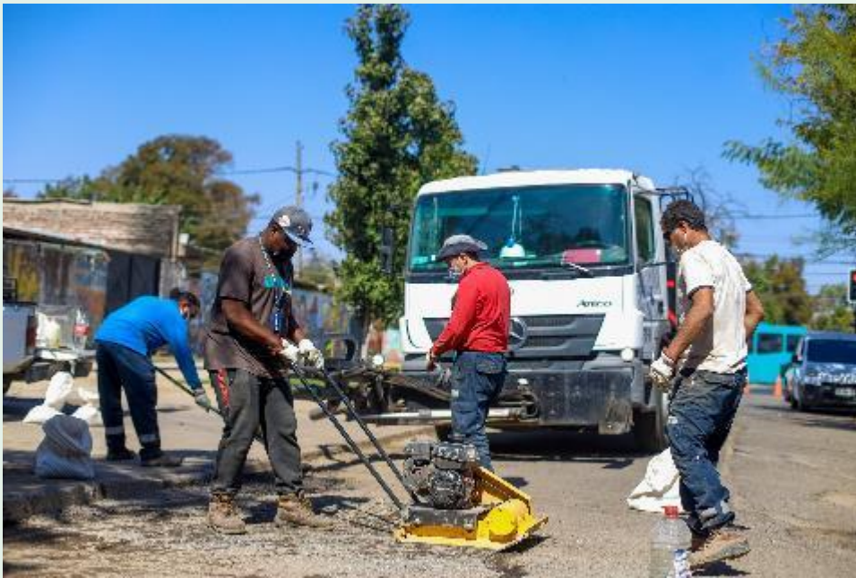
Fotografía 82 Reparación de baches en Federico Errázuriz con Ronda de niños
