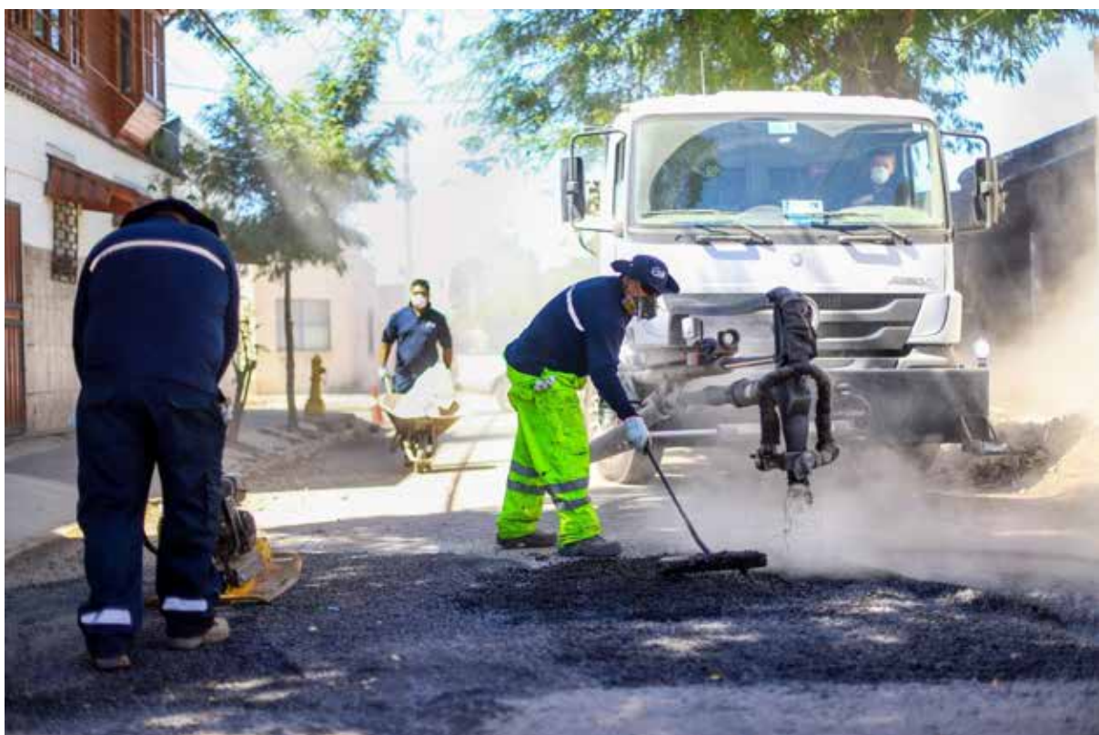
Fotografía n°32: reparación de baches en la comuna.
